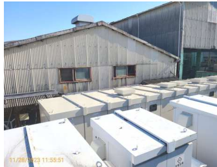
キュービクル更新工事
