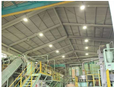
本社・センターLED工事
